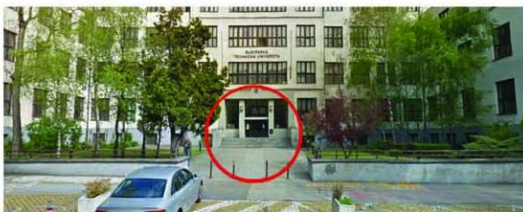
A3 - nie je zabezpečený bezbariérový prístup
